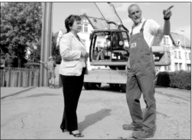
Die Umweltpolitikerin, Uta Windisch, lässt sich auf der ZWW-Baustelle in der Oberen Hauptstraße in Neukirchen durch den Werkpolier Frank Löschner über den Fortgang der Arbeiten informieren.
