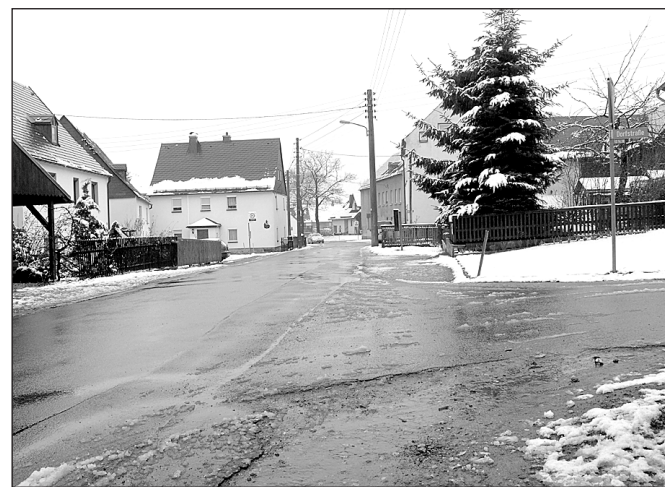
Im Schwarzenberger Ortsteil Bermsgrün wird auf einer Länge von 495 Metern ein Mischwassersammler verlegt. Foto: ZWW
