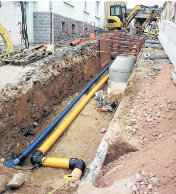
Auf einer Länge von 500 m wechseln die Wasserwerke Westertal in Zschorlau auf der Herzogstraße die Trinkwasserleitung aus.
