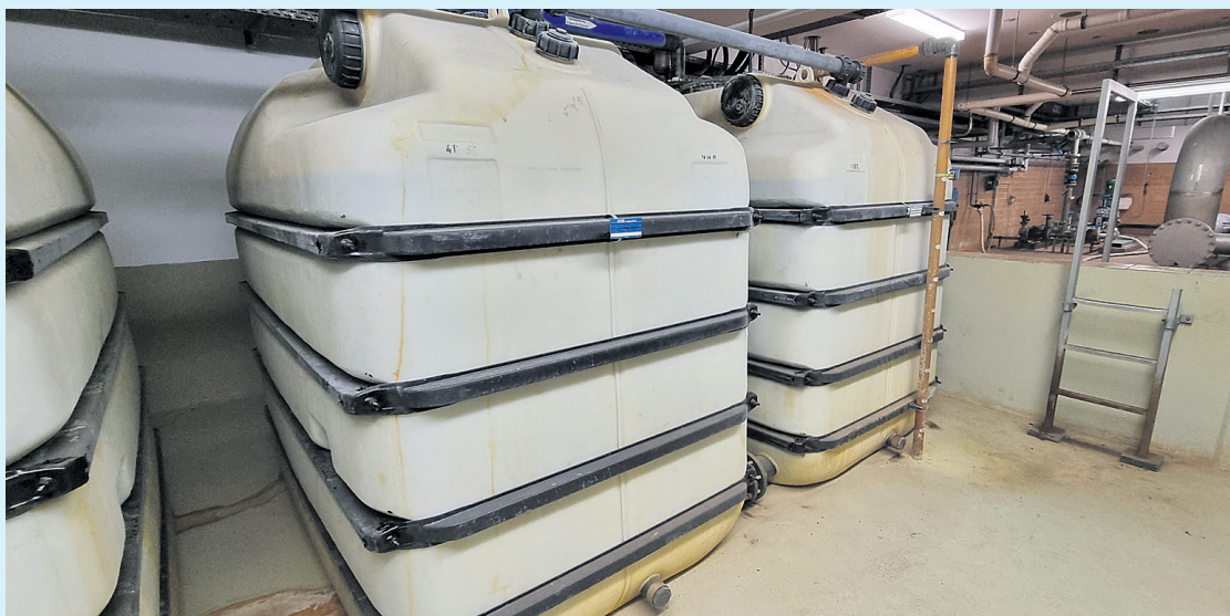
In diesen Behältern unter der Kläranlage befindet sich das mittlerweile sehr rare und stark verteuerte Eisen III-chlorid.
