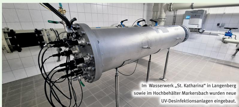
Im Wasserwerk „St. Katharina“ in Langenberg sowie im Hochbehälter Markersbach wurden neue UV-Desinfektionsanlagen eingebaut.
