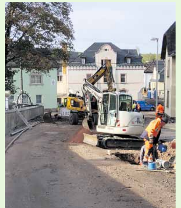
Baumaßnahmen in Stützengrün in der Auerbacher Straße.
