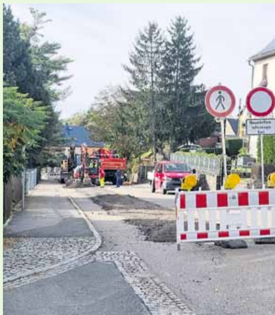
In Bernsbach werden in der Ernst-Schneller-Straße Trink- und Abwasserleitungen neu verlegt.
