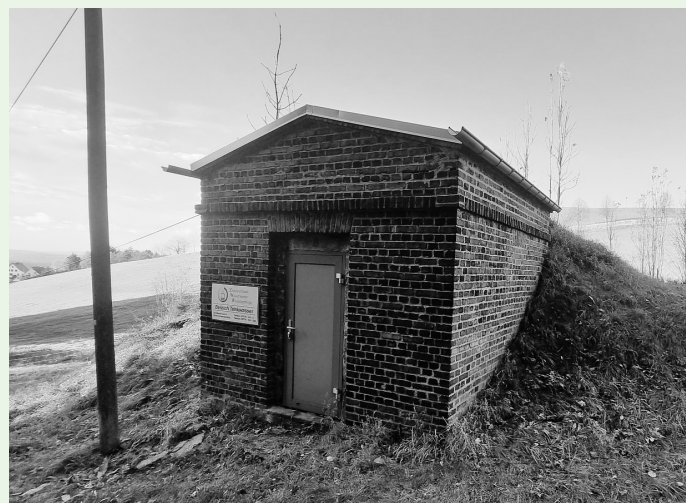
Der alte Bechstein-Hochbehälter wird noch in diesem Jahr abgerissen.
