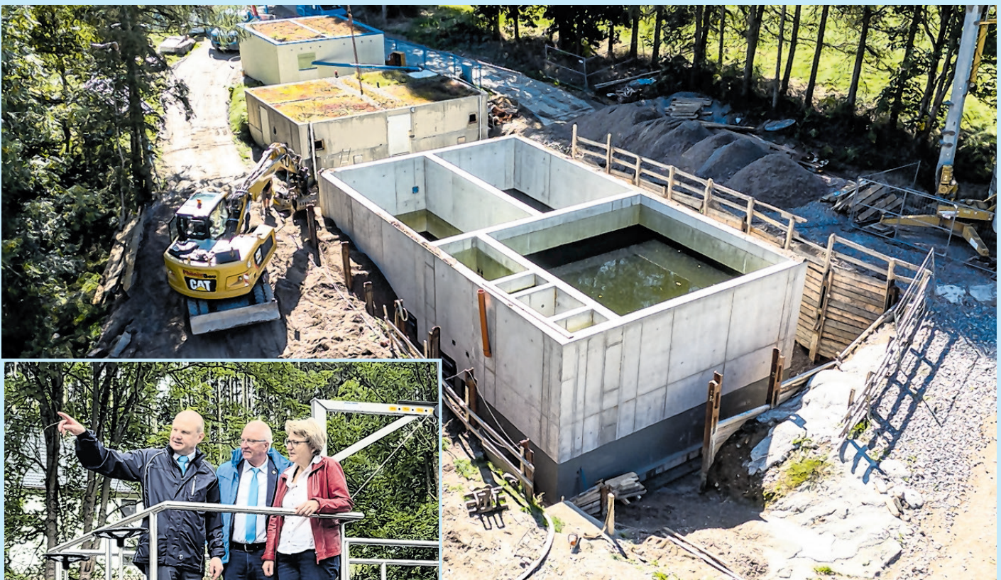
Unter beengten räumlichen Verhältnissen wurden auf der Kläranlage Hermannsdorf die biologische Reinigungsstufe und das Zulaufpumpwerk erneuert. Zusätzlich erfolgten der Einbau einer Phosphor-Fällungsanlage und die Modernisierung der Steuerungstechnik. Kleines Bild: Dr. Frank Kippig (Geschäftsführer ZWW), Verbandsvorsitzender ZWW Wolfgang Leonhardt und die Bürgermeisterin von Elterlein Annette Ficker (v.l.n.r.) im Arbeitsgespräch auf der erneuerten Anlage.
